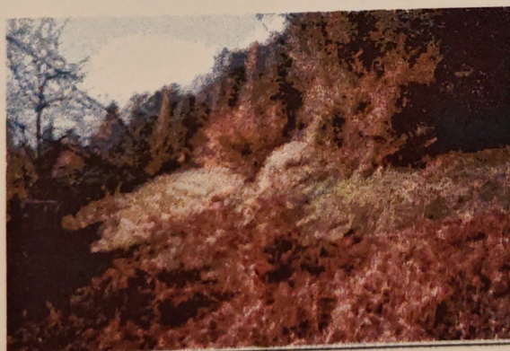
Foto 4: area vista da nord-est
